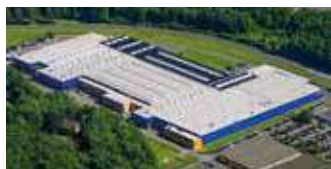
Hörmann KG Eckelhausen, Allemagne
